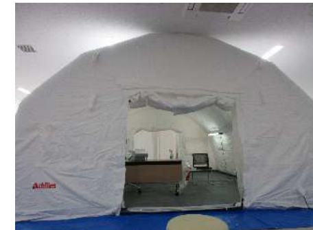
陰圧テントの設営
