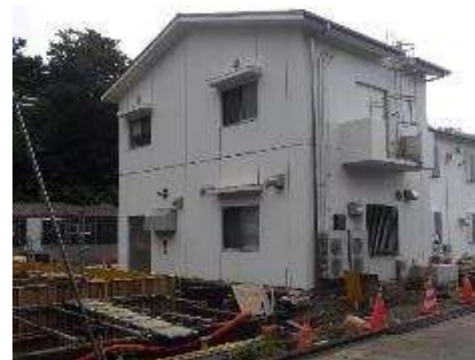
補助事例 (小笠原村浄水場更新事業)
